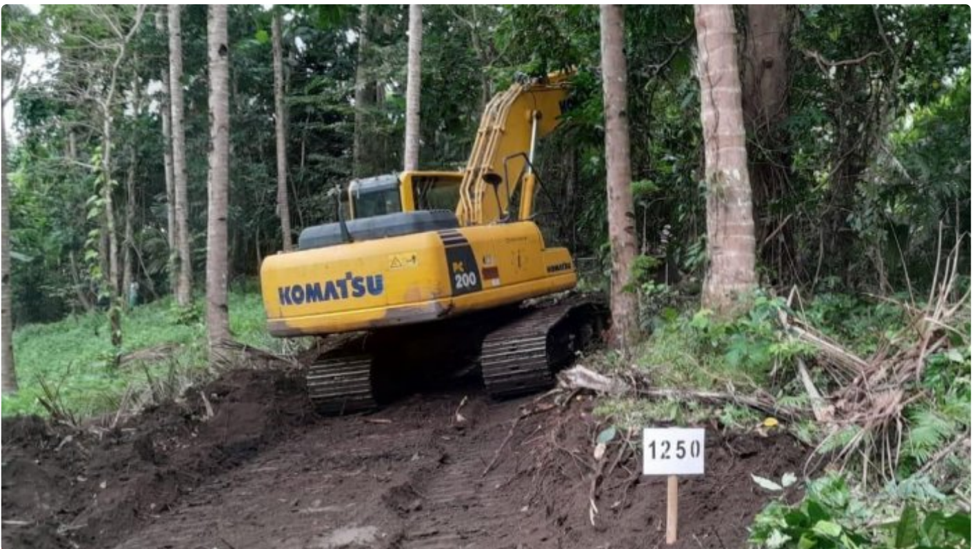
Pekerjaan Pembukaan Jalan Pertanian Oleh Satgas TMMD Ke-116 Kodim 1310 Bitung
