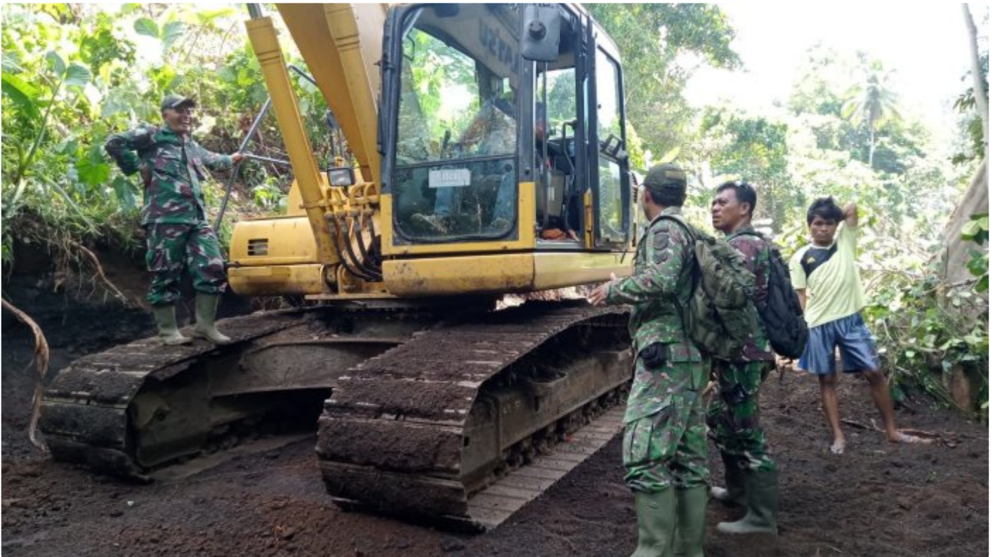
Ribtisan Jalan Pertanian pada TMMD Ke-116 Tahun 2023 Kodim 1310 Bitung
